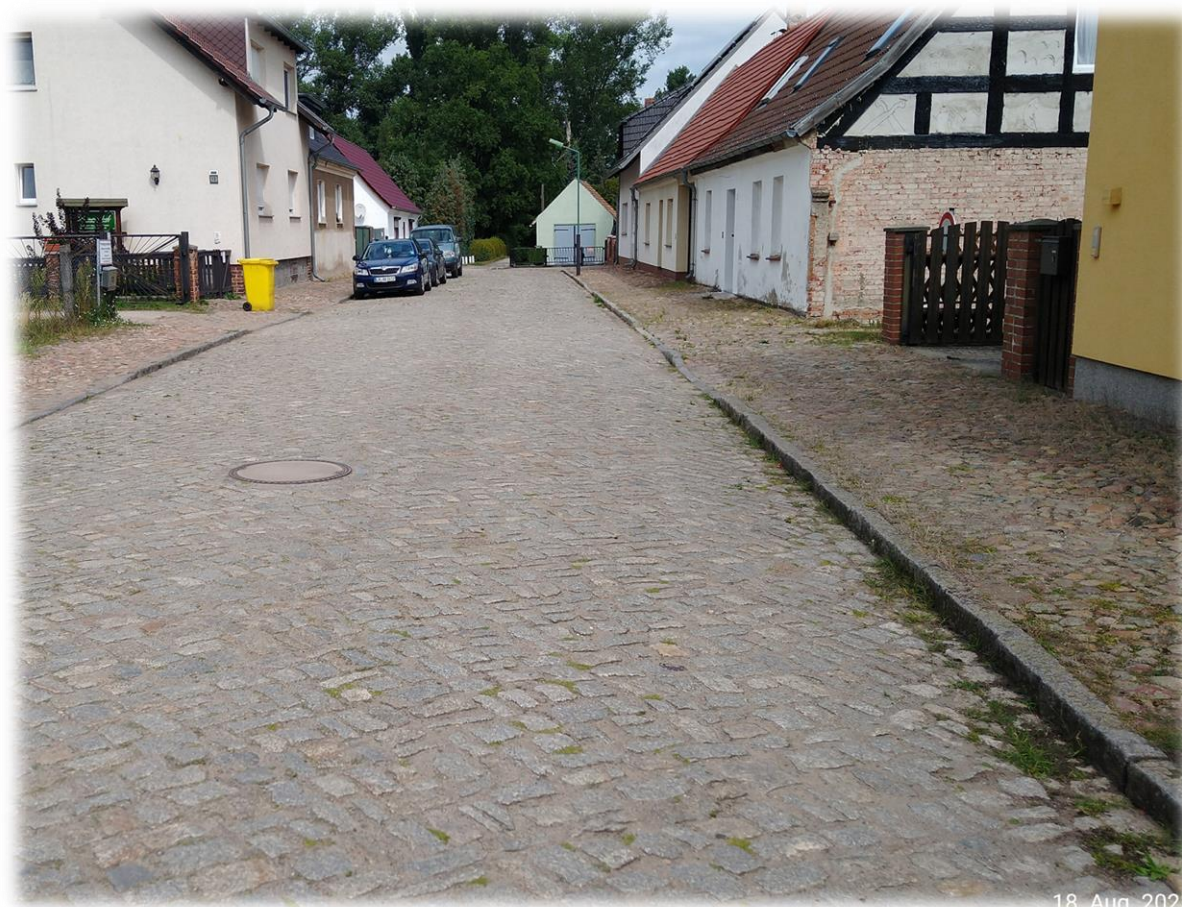
Abbildung 4: Neugasse – Fahrbahnbelag vor Maßnahmenbeginn
